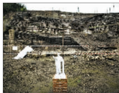
这是11月30日拍摄的意大利庞贝古城遗址发生垮塌的建筑。意大利庞贝古城遗址一座重要建筑11月30日发生垮塌,这是11月份庞贝古城遗址第二次出现建筑物垮塌事件。据意大利安莎社报道,此次发生垮塌的是庞贝古城遗址内“道德者之家”的外墙,庞贝古城遗址负责人帕帕佐普洛斯认为近日庞贝地区连降暴雨是垮塌主因。(新华社发)
