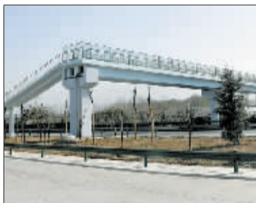
联通高速公路两侧的立交桥。
