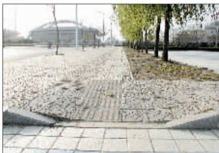
缘石坡道和盲道
