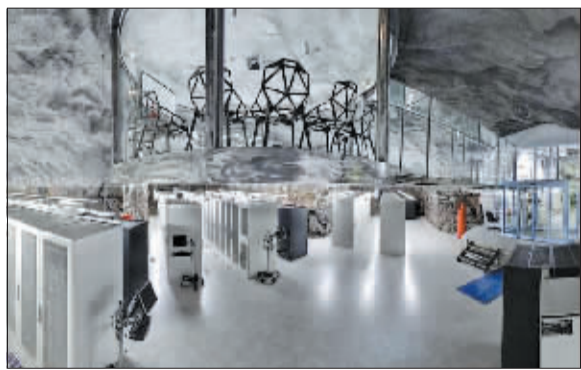
数据中心的「悬空」会议室。
