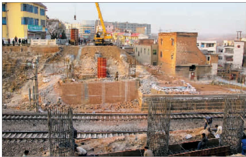
东关桥施工现场。
