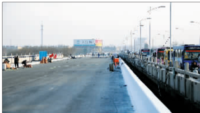
新洛阳桥施工进入尾声。
