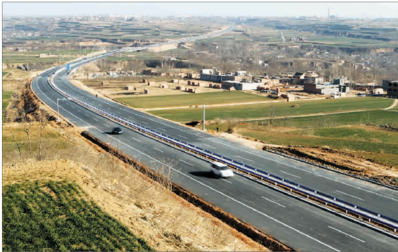
昨日,经过市公路局建设者的辛苦施工,洛吉快速通道市区至孟津朝阳段主体建成通车。该路段南起定鼎北路与310国道交会处,北至朝阳镇,全长8公里,按双向4车道一级公路标准建设,设计时速80公里,路基宽26米。这条大道的建成通车,拉近了孟津与市区的距离,方便了沿线群众的出行。 记者 梅占国 通讯员 宋新成 摄影报道
