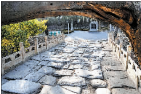
桥面青石磨损严重，还留有明显的车辙痕迹。
