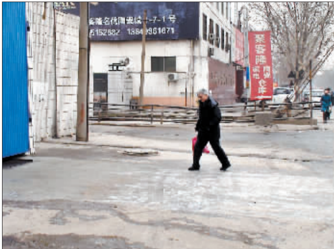
春都路一垃圾中转站门前的冰层延伸至人行道上。
