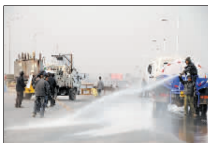
通车在即,工作人员清洗新桥桥面。
