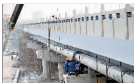
工人们在新桥桥面下架设水管。
