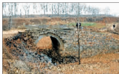
铁佛寺桥如今仍作为生产便桥使用。
