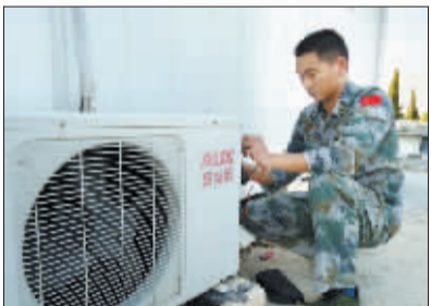
焦五龙在修理维和部队兵营里的空调。
