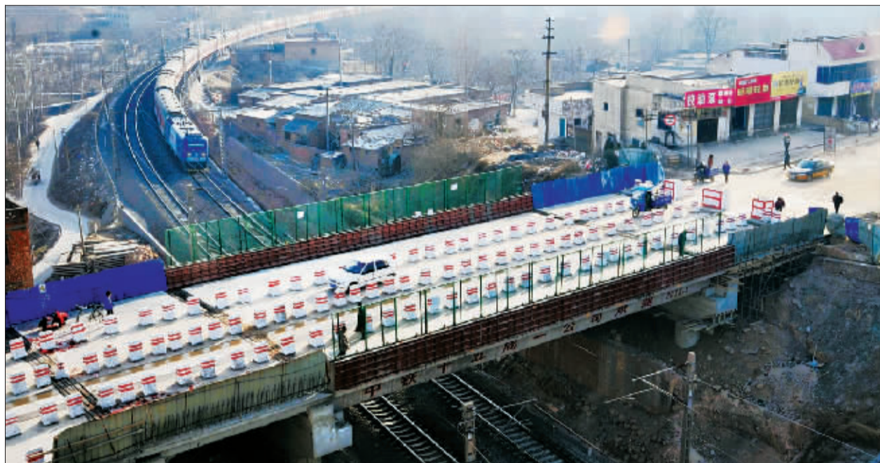
新安县东关立交桥通车现场。
