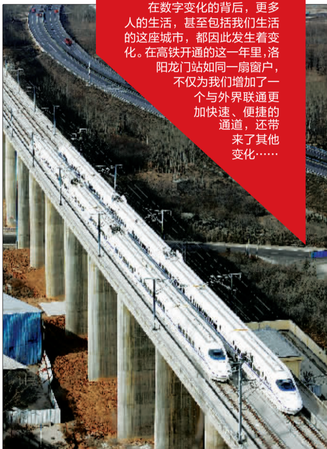
正在运行的郑西高铁。
