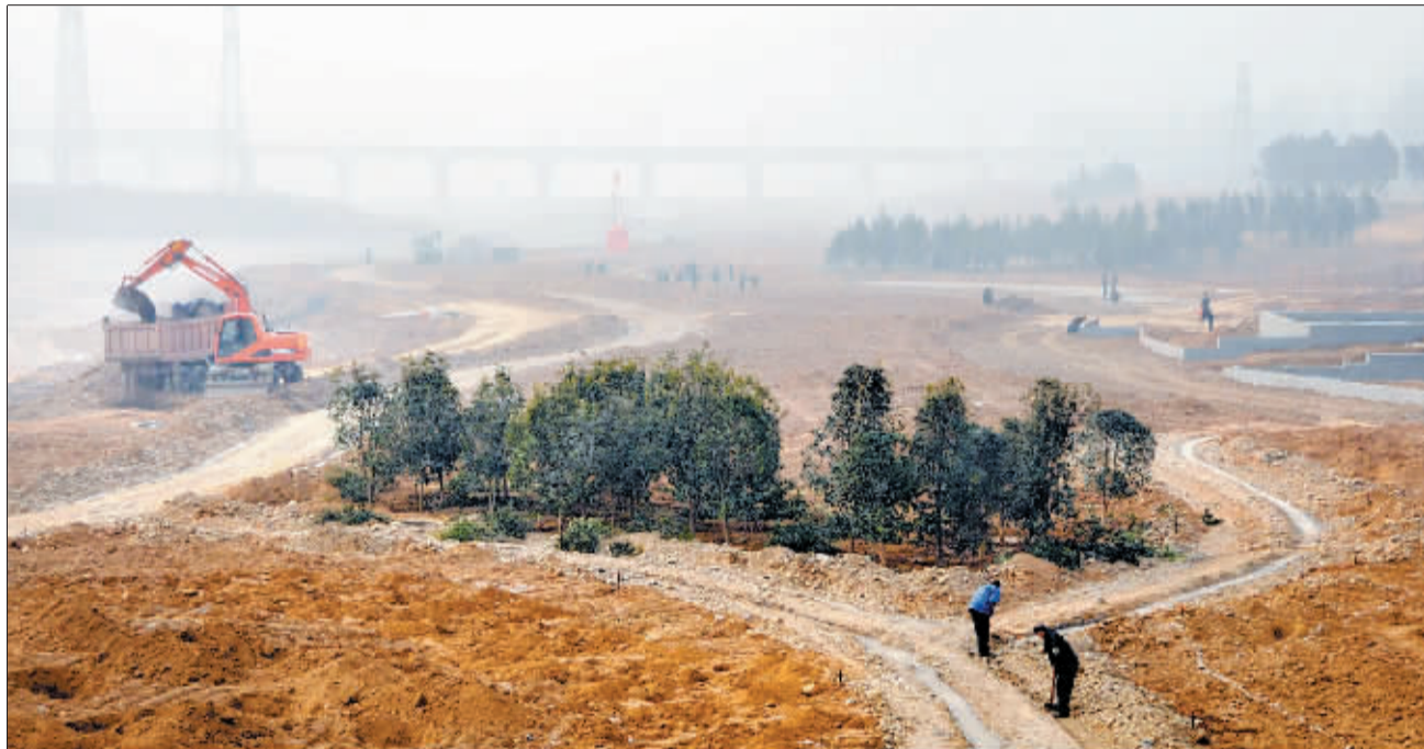
伊滨公园龙门古韵段正在如火如荼地施工。
