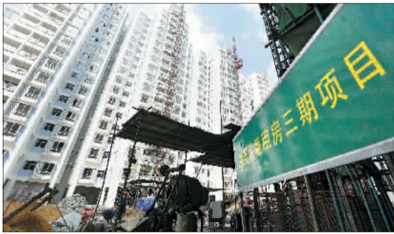
海口市建设中的一处廉租房小区。
