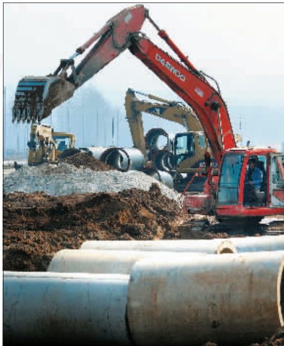
施工中的伊滨区伊洛大道。
