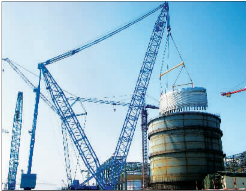
今年2月22日,三门核电1号机组CA03模块成功吊装就位。位于浙江省三门县六敖镇的三门核电一期工程采用世界上最先进的第三代压水堆核电技术,将建成全球首座AP1000核电站,总装机容量将达到750万千瓦,该电站1号机组计划于2013年建成发电。(新华网图片)
