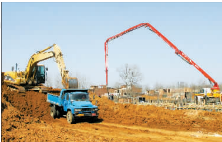
龙华中专正在建设中。记者 石蕴璞 摄
