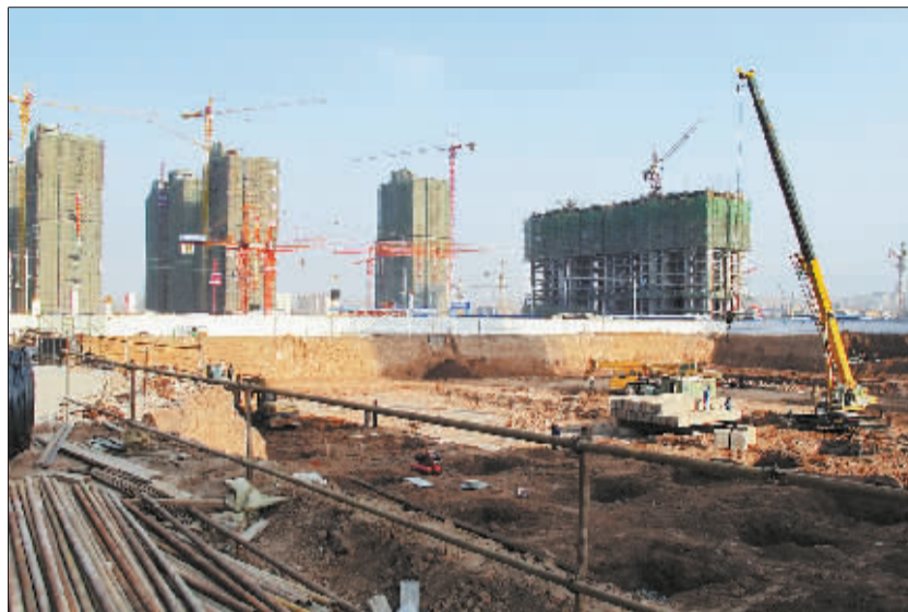
1号安置小区施工现场。 石蕴璞 摄
