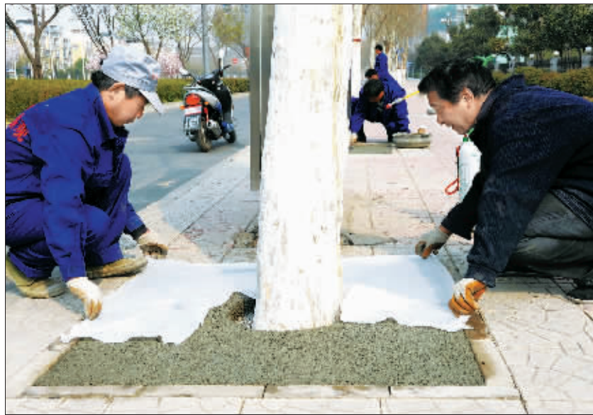
施工人员在太康路为行道树树坑铺设新材料。
