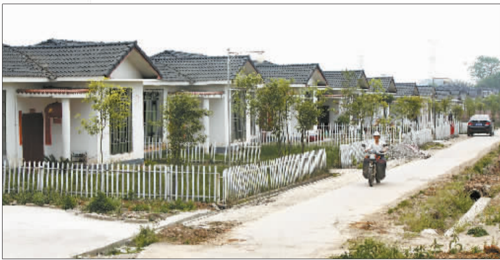
江油市太平镇居民安置点
