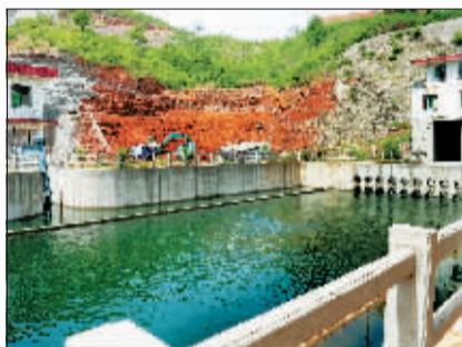
一期工程大型分水闸。
