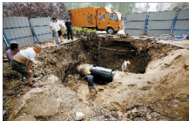
12日上午,爆裂的管道修复完毕。
