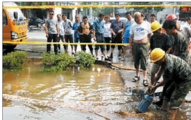
抢修人员用抽水机抽积水。
