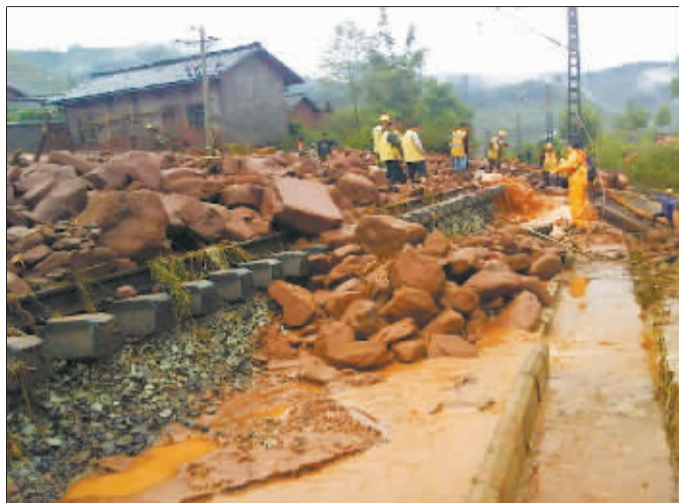
救援人员在中断的铁路上进行排险作业。(新华社发)
