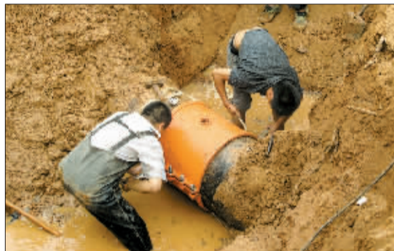
市水务集团工作人员修复自来水管。
