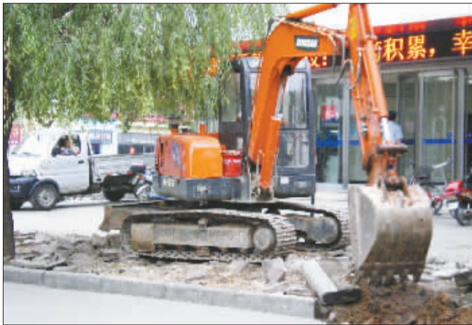
江西路人行道施工现场
