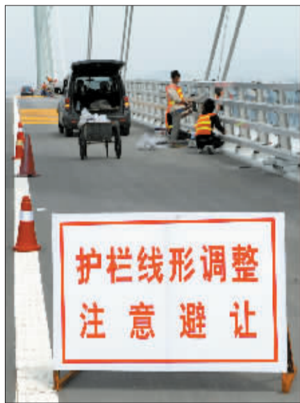
7月5日,工人在进行护栏线形调整施工。 新华社记者 李紫恒 摄
