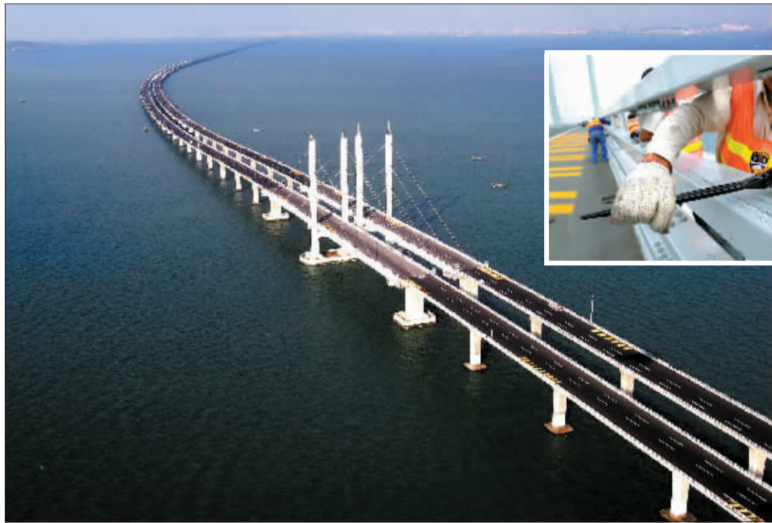
7月5日,工人在紧固大桥护栏上的螺丝。 新华社记者 李紫恒 摄
