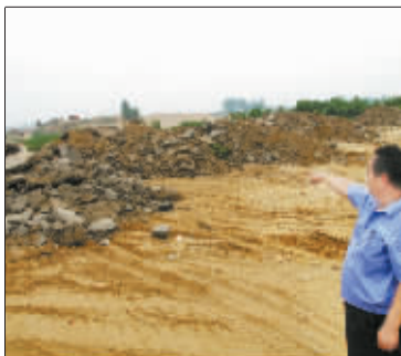
据河渠管理处工作人员说,这些建筑垃圾至少有100立方米。
