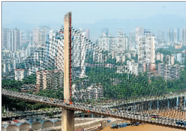
重庆石门嘉陵江大桥通车后不久就经常性地缝缝补补。
