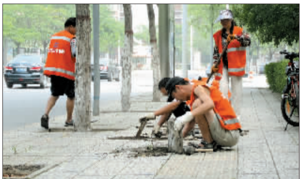
施工人员在更换道板砖。
