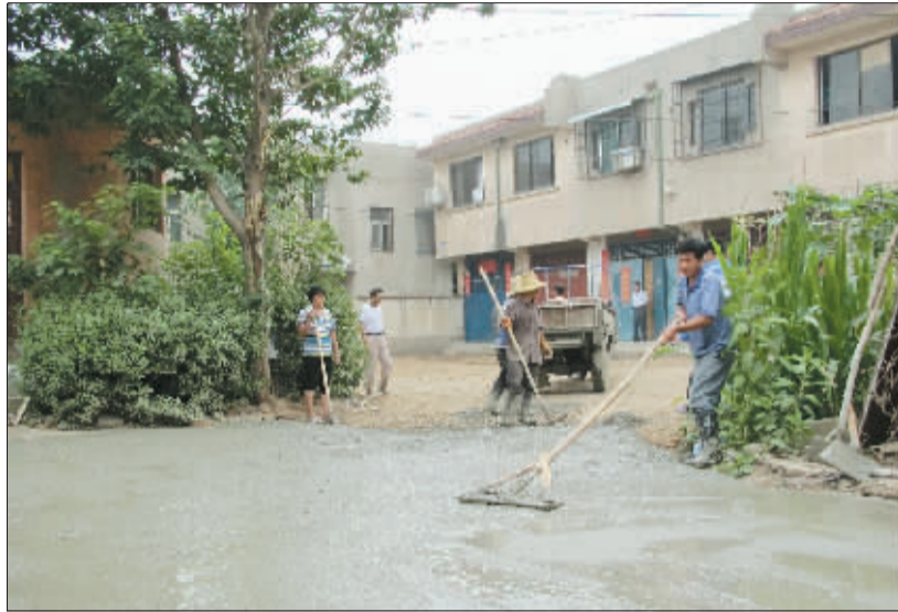
医药城小区北花园正在铺混凝土路面。
