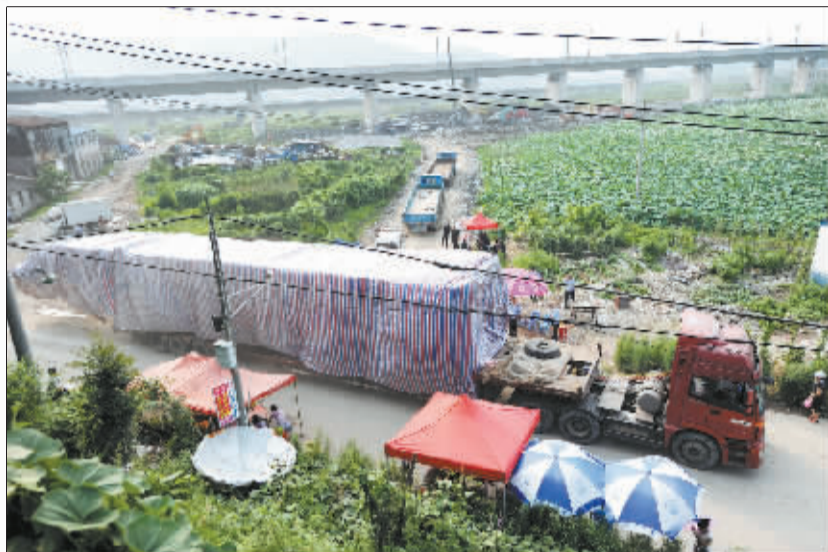
脱轨车厢打包运离现场。 新华社记者 王定昶 摄
