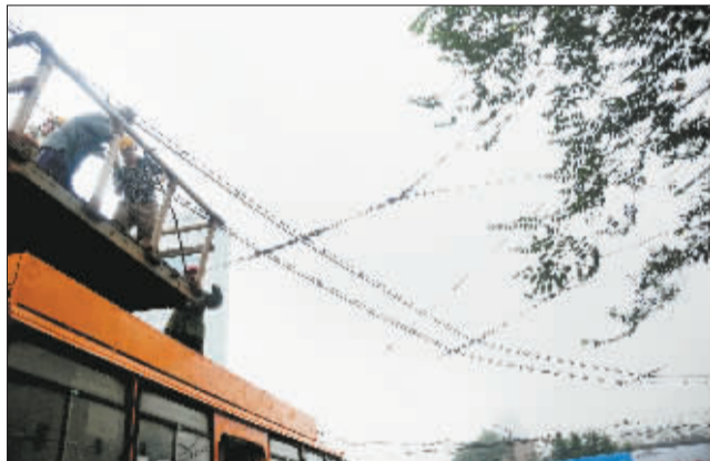
维修人员正在抢修。
