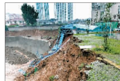
昨日凌晨 3 时许，涧西区西苑桥附近一在建工地的基坑因雨水浸泡局部塌陷，殃及附近“君临天下”小区的车子棚，有三四辆自行车被埋坑中。当日下午，记者在现场看到，塌陷的基坑长 20 余米，紧邻“君临天下”小区车棚。据负责该小区物业的洛阳兴隆花园物业管理有限责任公司一孙姓工作人员介绍，有三四辆自行车被埋坑中。
