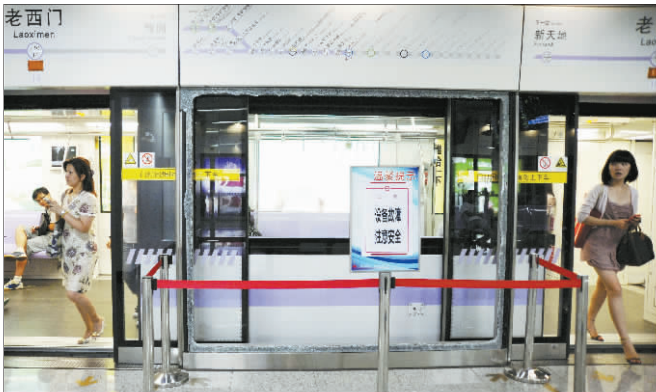
7月19日,乘客在发生玻璃屏蔽门爆裂事故的上海地铁10号线老西门站下车。
