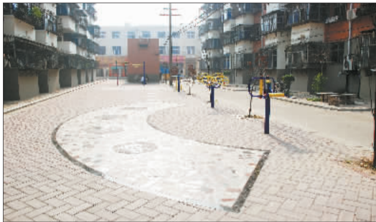
全面整改后的春都路161号院。
