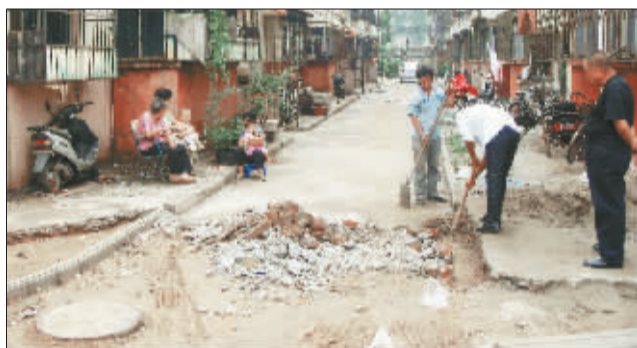
凯旋西路67号院的路面正在整修中。
