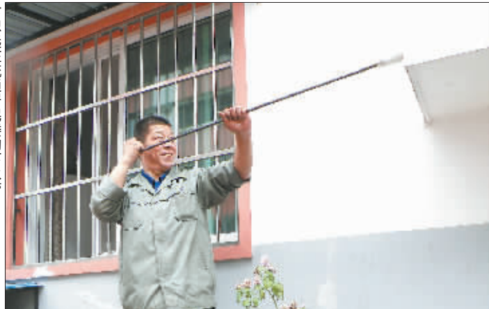
卞恕远在疏通居民楼的下水管。
