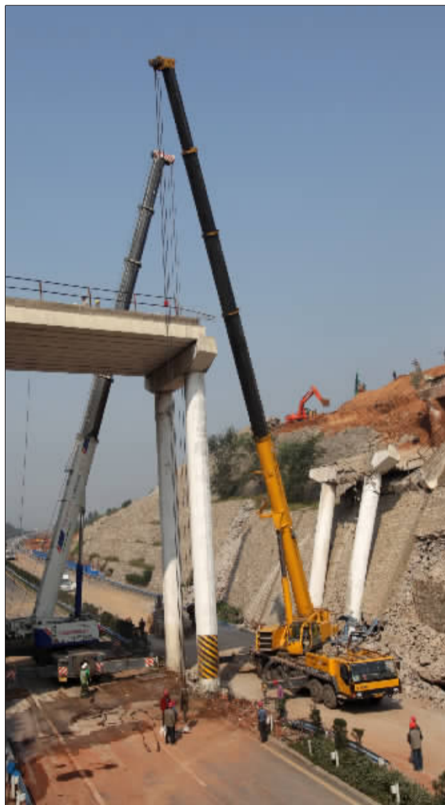
昨日,抢险人员尝试用两台吊车同时起吊边梁,但未能奏效。
