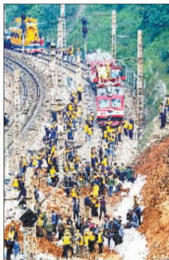
众多抢修人员奋战在事故现场。
