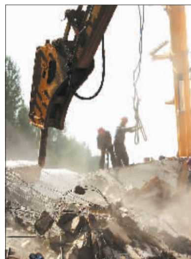
分解庞大桥体。
