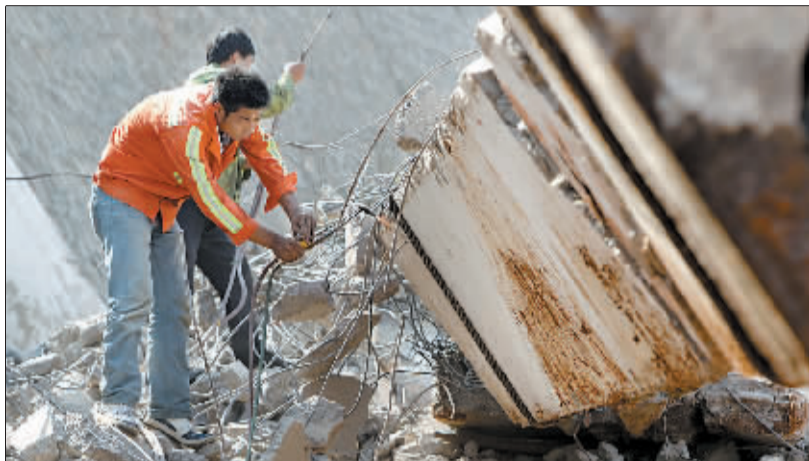
施工人员在现场清理残存桥体和滑塌土石。
