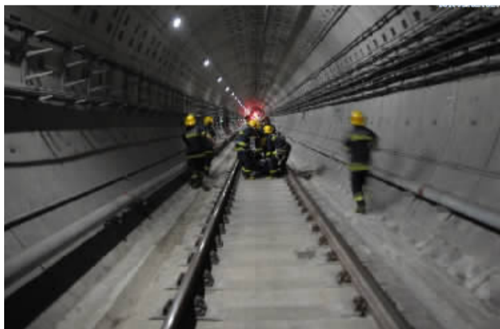
救援人员在地铁线路内紧张抢险。
