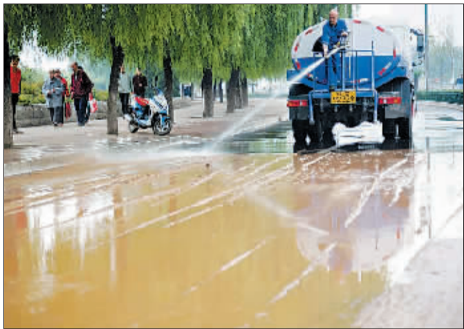
供水管道修复完毕后,工作人员在清洗路面。
