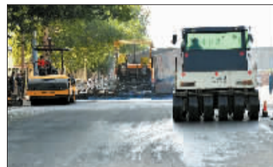
昨日的天津南路施工现场。
