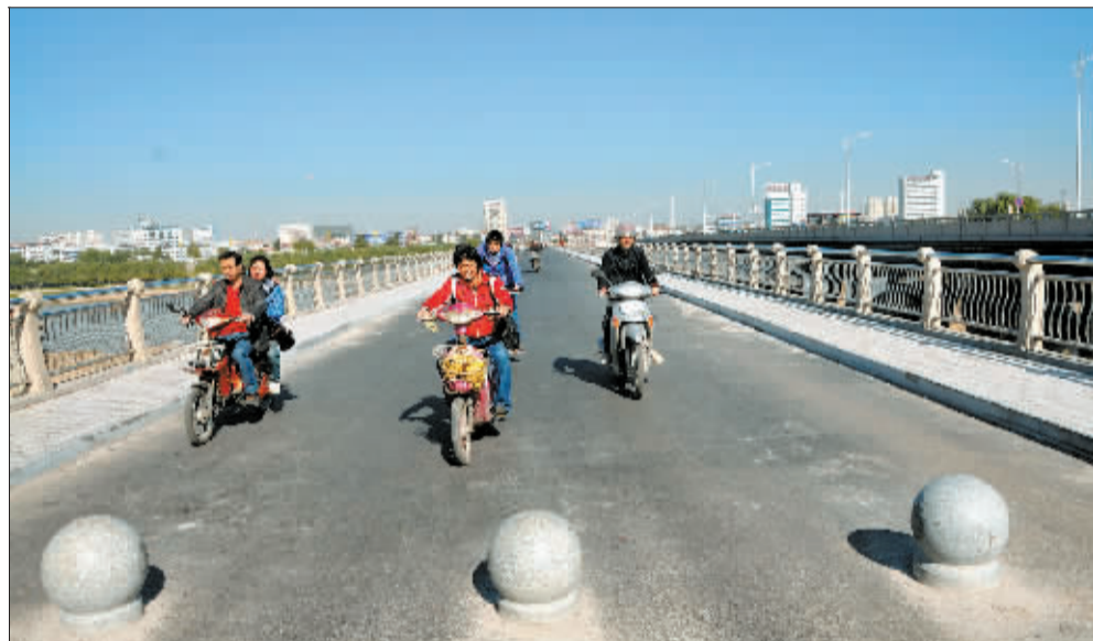
16日,老洛阳桥桥面改造工程全面完工恢复通行。该桥建于1955年12月,全长424米,宽7米,是新中国成立后我市修建最早的桥,它记录着古都洛阳的沧桑历史。如今,这座专供非机动车和行人通行的大桥,新铺设的沥青路面、新更换的大理石桥面道牙和人行道地砖,将该桥面装饰得焕然一新,很好地保护了这座宝贵的建筑。记者 梅占国 通讯员 贾光明 摄
