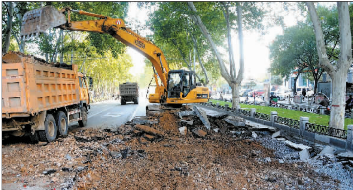
市政建设集团自16日凌晨全面展开施工。
