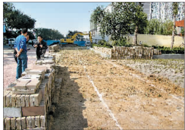
工人们正在路边为敷设新管道做准备。
