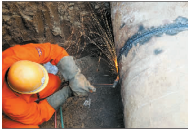
市热力公司工程人员正在切割管道。
